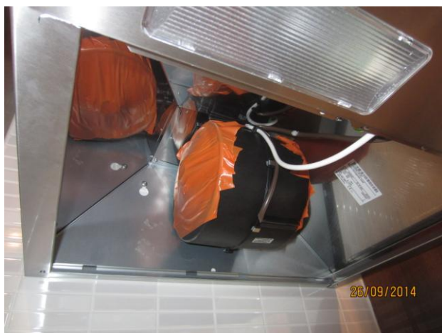
Kuvat 3 ja 4: Liesituulettimen putkisto tiivistettiin teippaamalla
