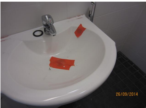
Kuvat 9 ja 10: Altan viemärit tiivistettiin teippaamalla
