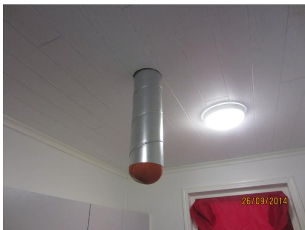
Kuvat 1 ja 2: IV-järjestelmän putkisto tiivistettiin tiivistyspaloilla
