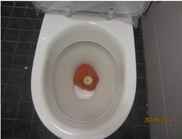
Kuvat 5 ja 6: WC-istuinien viemärit tiivistettiin kumipalloja käyttäen
