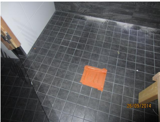
Kuvat 7 ja 8: Lattiakaivot tiivistettiin teippaamalla
